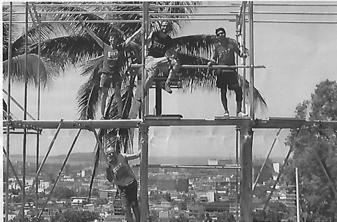
Edoardo Ceresa e soci durante la costruzione della casa
