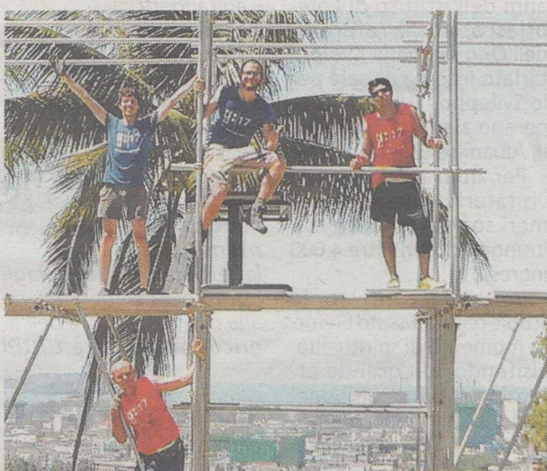
Una fase della costruzione della casa
