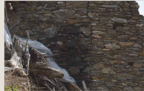
Macchia da combustione
